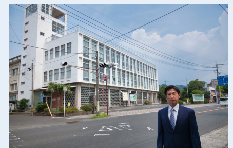
垂水市現庁舎（2023.9）
